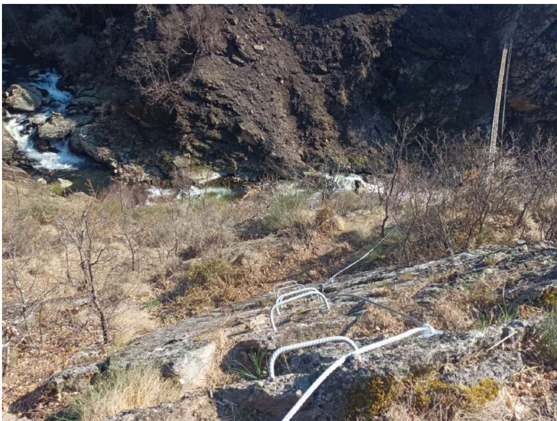
Tramo de ascenso vertical por grapas
