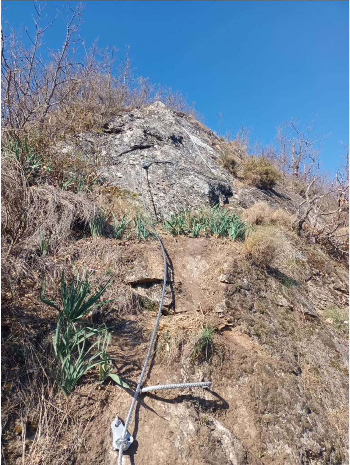
Tramo de ascenso vertical por grapas
