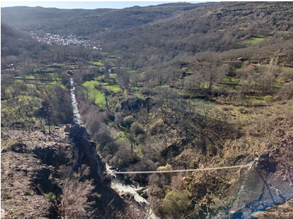
Puente tibetano y Vía Ferrata con un paso de cuerdas en paralelo
