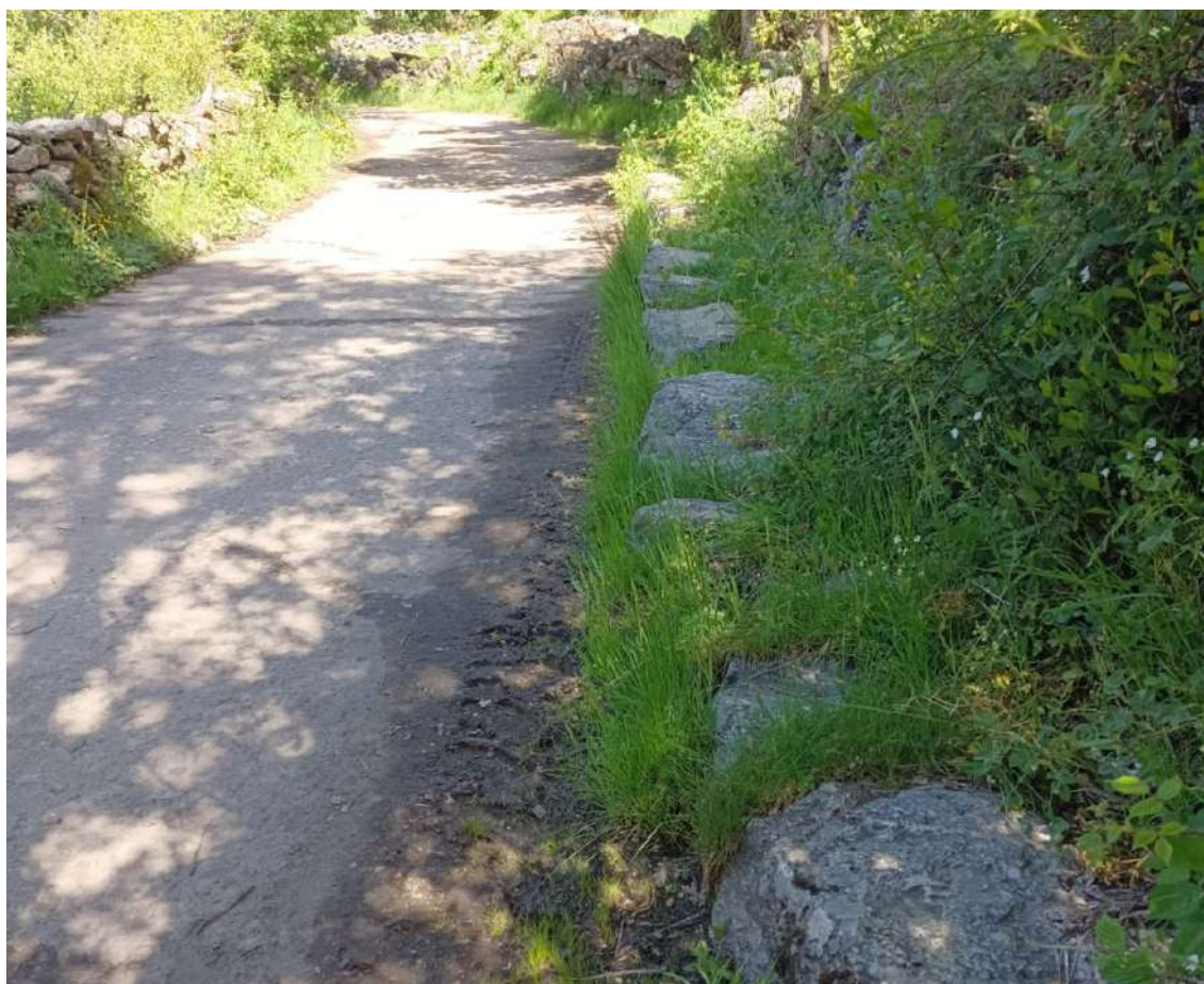
Calzada de Pontepedriño
